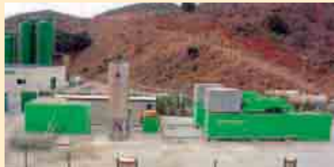
Planta de desgasificación y aprovechamiento eléctrico del Centro Ambiental "Los Ruices".
